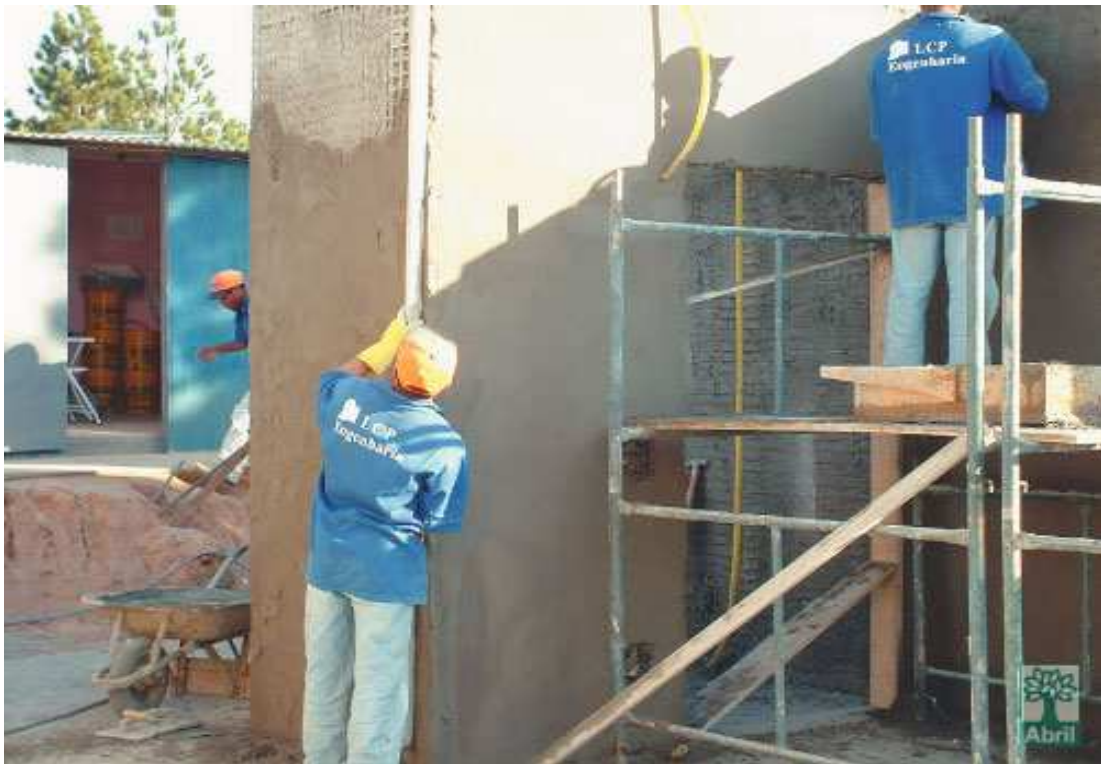
Uma máquina projetou argamassa estrutural sobre as placas, que viraram paredes monolíticas.
